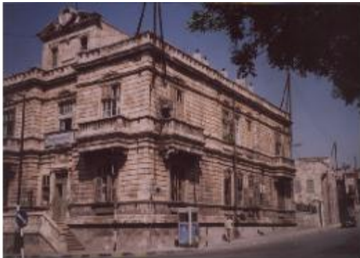
صورة رقم ( 39 ) مبنى الهجرة والجوازات - المصدر: الباحث
