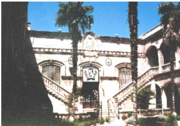
صورة رقم (40) مبنى مديرية الخدمات القديم - المصدر: الباحث
